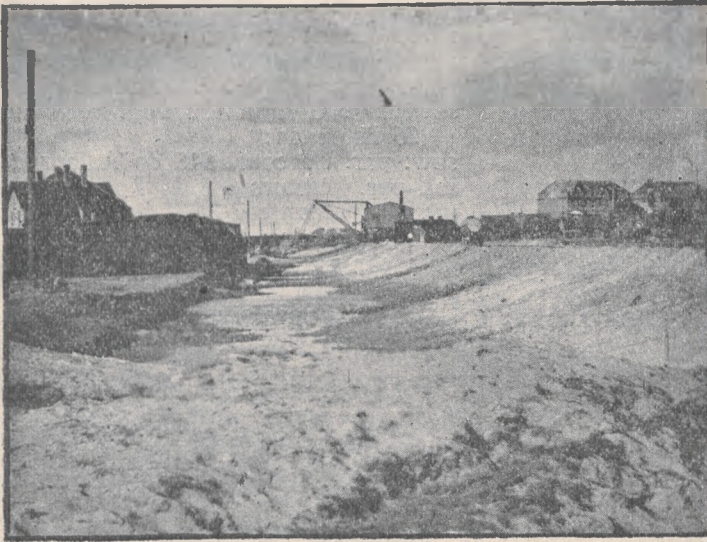
Basen, już częściowo pogłębiony „na sucho“, lecz jeszcze oddzielony od Wisły.
