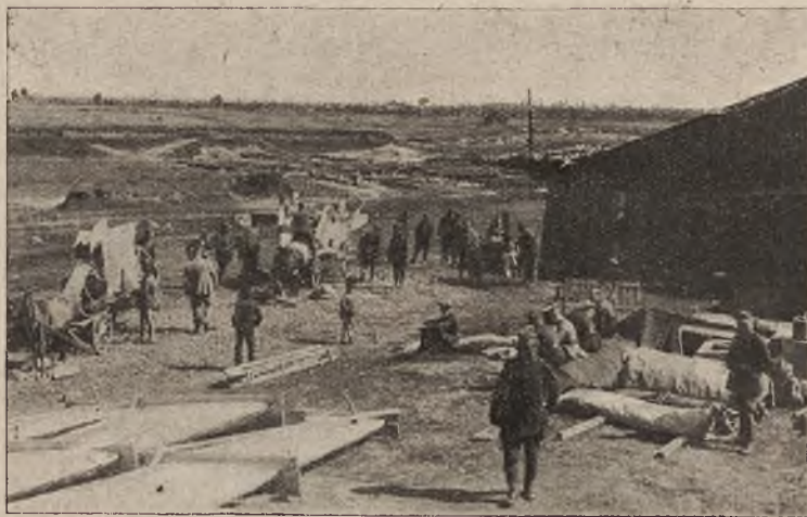
Przyjazd na stację w Nowym Targu.
