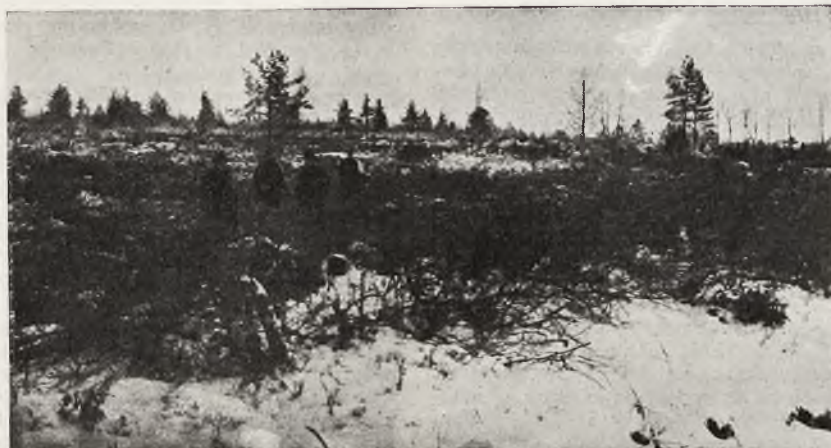
Usuwanie zadrzewienia na terenie przyszłego lotniska w Nowogrodzku
