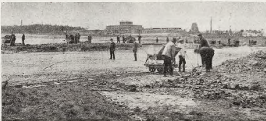
Prace przygotowawcze na terenie przyszłego lotniska
