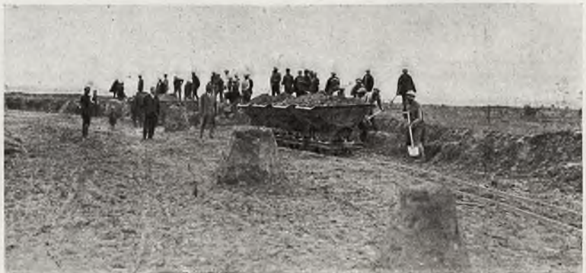
Prace niwelacyjne na lotnisku L. O. P. P. w Baranowiczach
