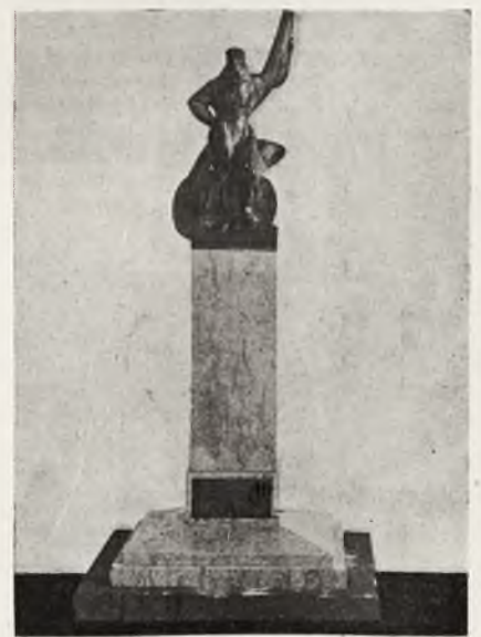
Na Placu Unji Lubelskiej, w Warszawie, rozpoczęto już roboty przy budowie fundamentów pod pomnik poległych lotników.
