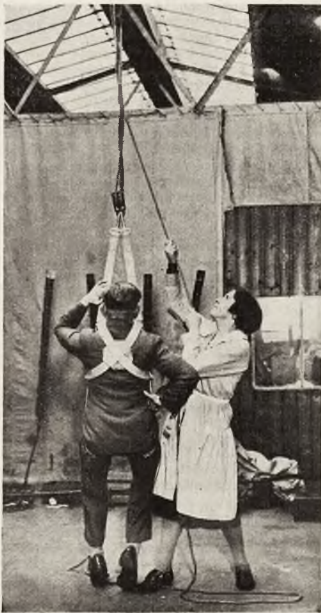
Próba wytrzymałości spadochronu
