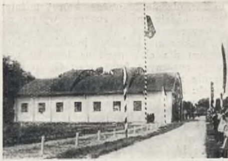
Hangar na lotnisku w Łucku.
