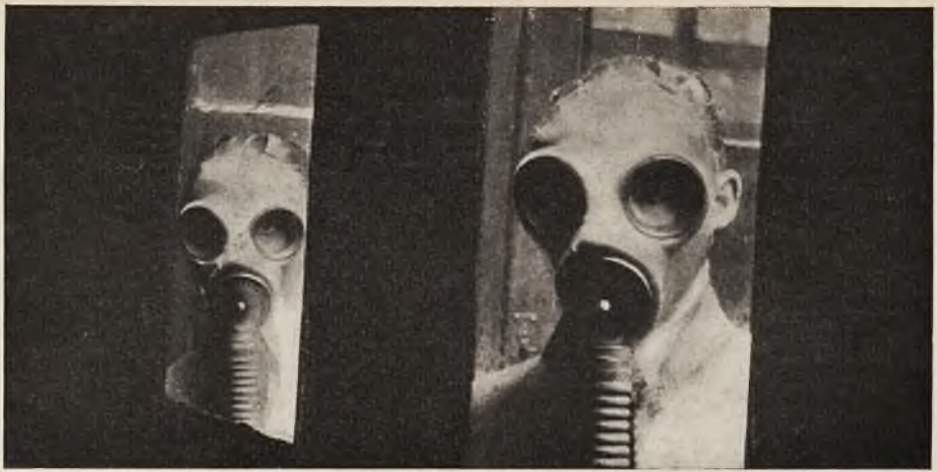
W komorze gazowej.
