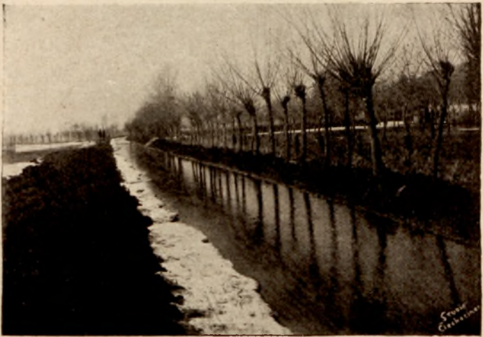
Fragment der Entwässerungsarbeiten.
