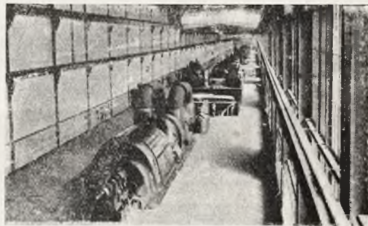
Rys. 11. Część hali maszynowej centrali Golpa Zschornewitz
