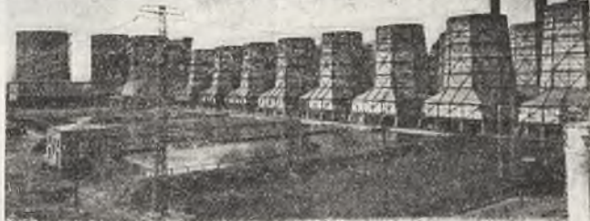
Rys. 18. Trzy nowe chłodnie betonowe o wydajności chłodni 14000 m 3 /h oraz baterja dawniejszych chłodni z odstożnikami
