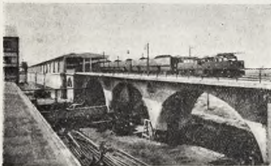
Rys. 5. Bunkry węglowe centrali Golpa/Zschornewitz
