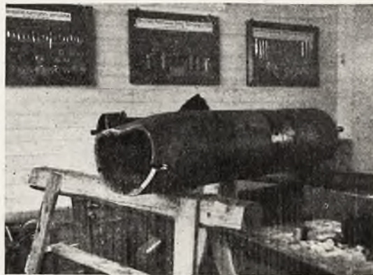
Rys. 8. Butla po wybuchu i pobraniu próbek do badania materiału.
