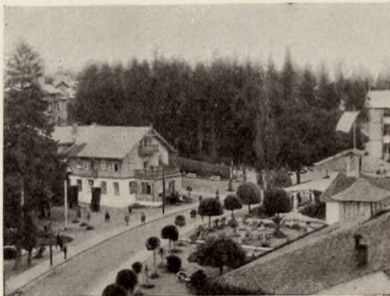
W Truskawcu – w schludnym ośrodku uzdrowiska
