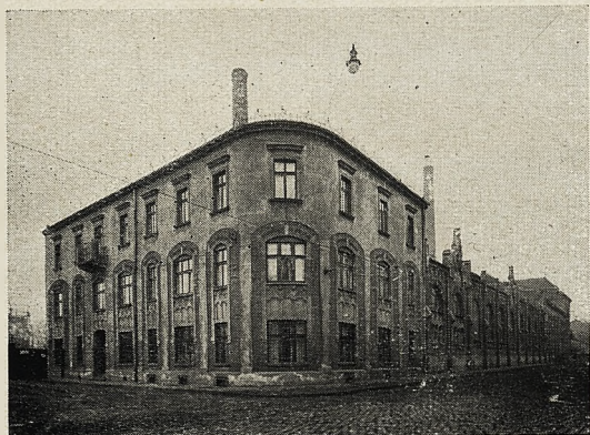
Widok głównego budynku elektrowni przy ulicy Dajwór
