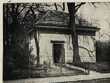
Stacja transformator. naprzeciw Głównej Poczty
