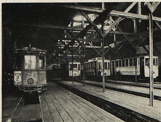
Remiza wozów wąskotorowych
