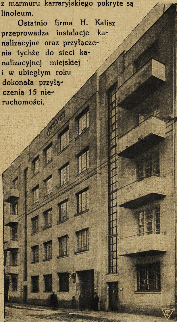
Elewacja frontowa nowowypbudowanego domu mieszkalnego przy ulicy Radwańskiej Nr. 2, w m. Łodzi.
