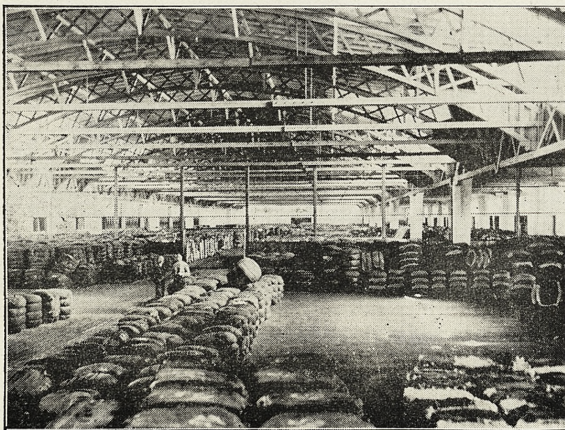
Wnętrze magazynu Nr. 6
