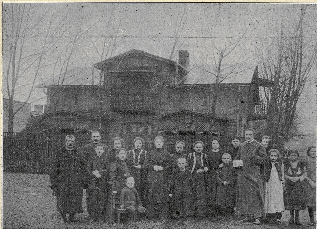
Żyrardów. Willa zamieniona na kaplicę (str. 104).
