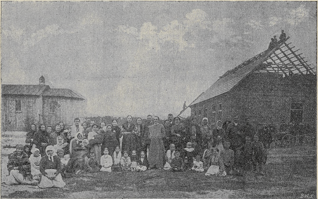
Jeruzal. Budowa domu parafialnego.
