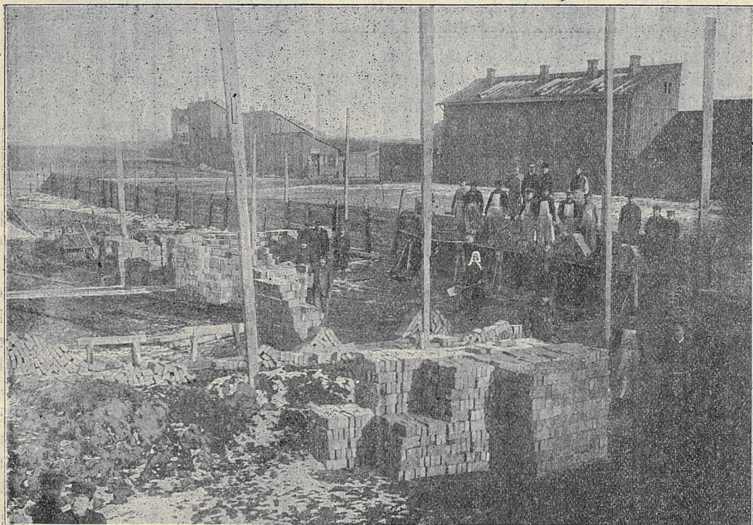
Budowa kaplicy na Pradze.
