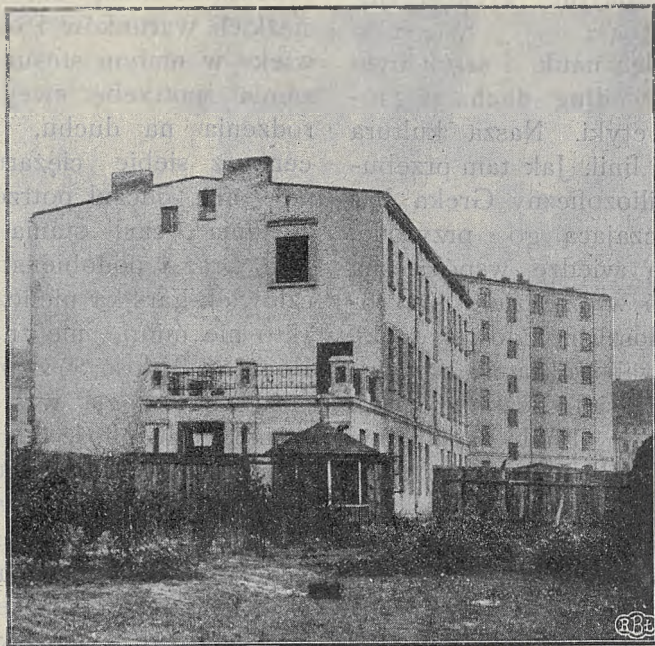
Budynek szkolny w Łodzi przy ul. Franciszkańskiej 27.
