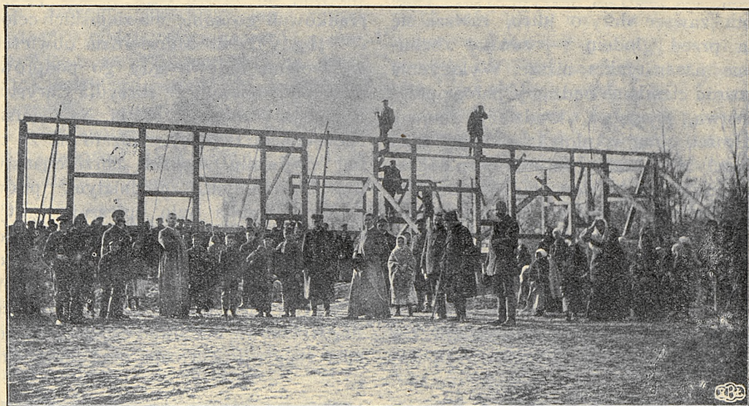
Budowa maryawickiego kościoła w Lesznie w listopadzie 1906 r.
