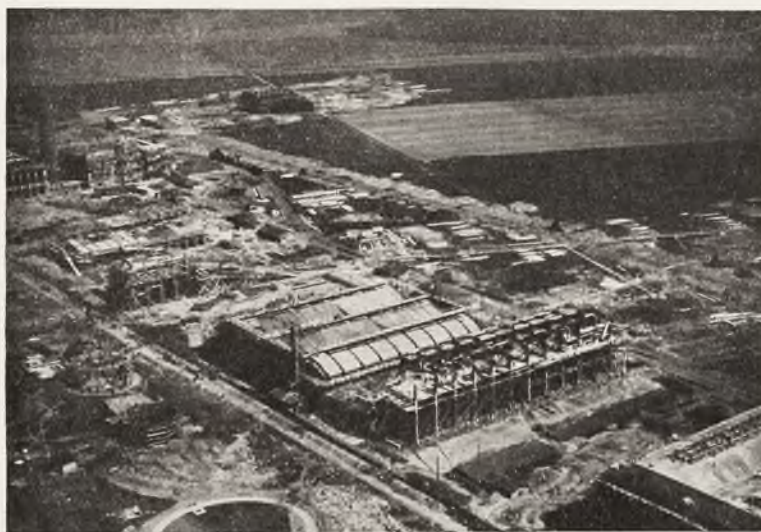
Fragment budowy Państwowej Fabryki Związków Azotowych w Tarnowie.
