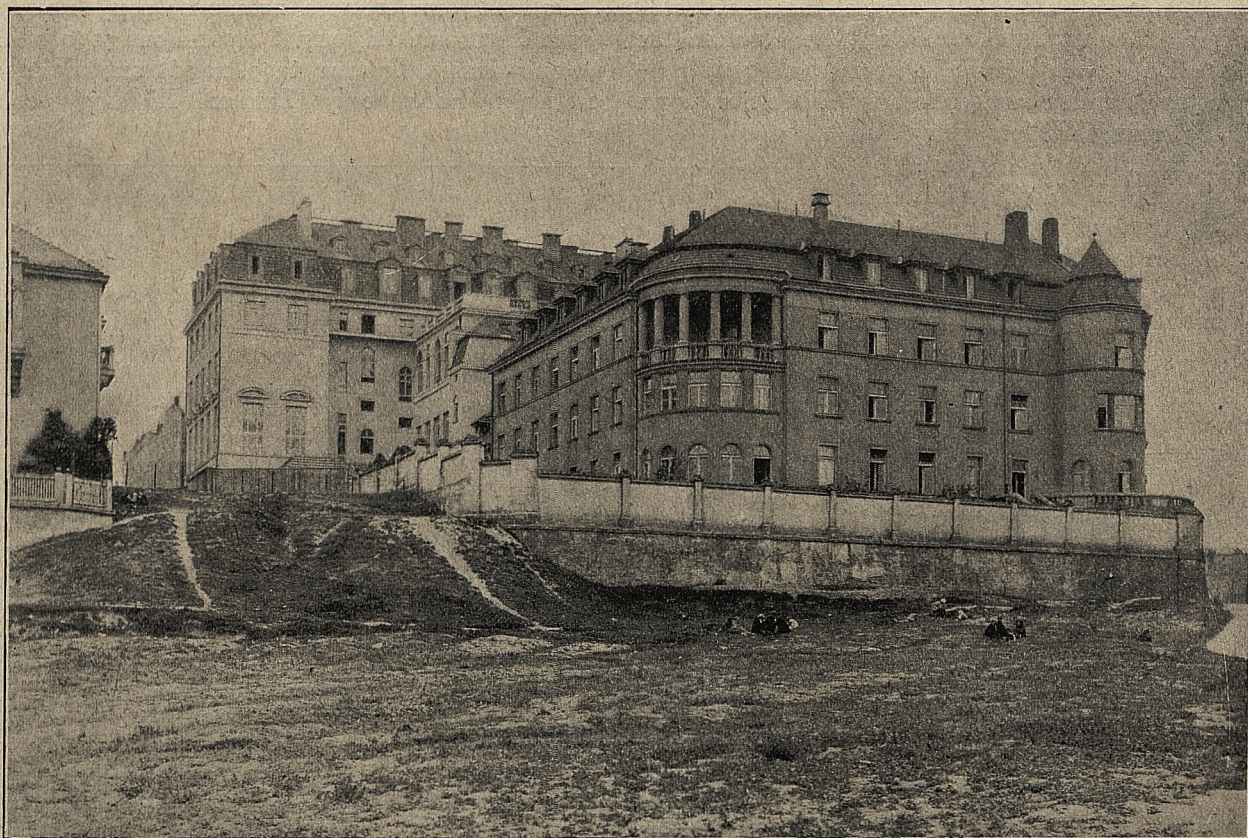
Gmach Zakładu i Szkoły Higjeny w Warszawie w Mokotowie.
