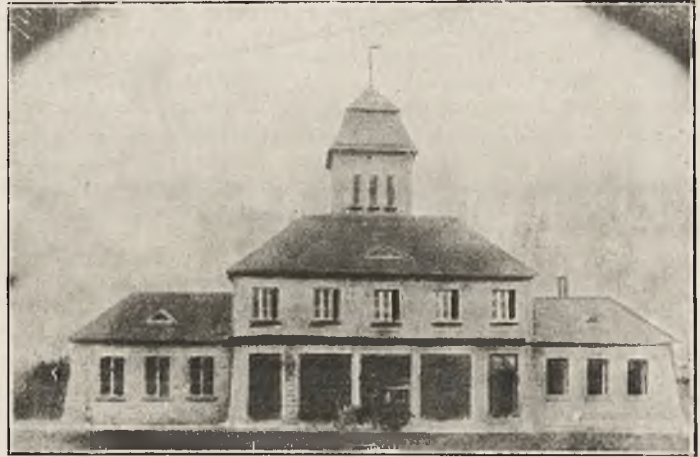
Nowowzniesiony budynek warsztatowo-administracyjny, ufundowany z ofiar i składek młodzieży polskich szkół średnich w Łodzi.
