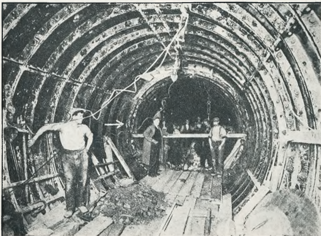
Budowa tunelu kolejki podziemnej.
