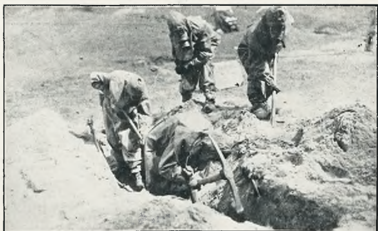
Pogotowie przy naprawie kabla podziemnego.
