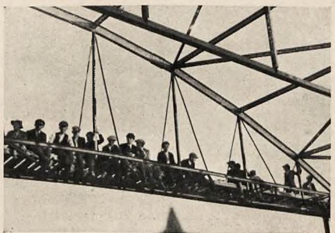
Galerją były wiązania stropu
