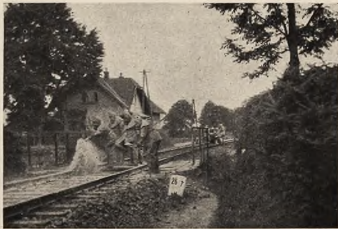
Odkazanie toru kolejowego
