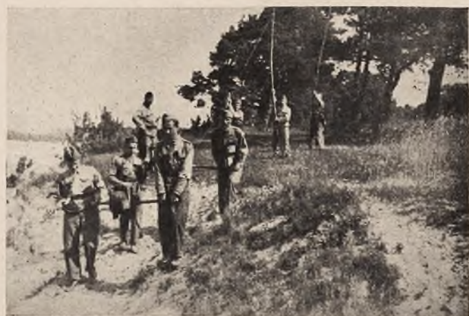
Zakładanie linii telefonicznej
