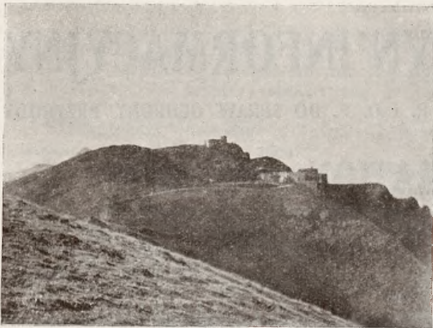
Ryc. 2. Widok na dwie nowe budowle na Kasprowym Wierchu w dniu 7 września 1937 r.
