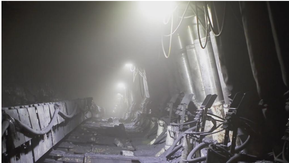
Rys. 18. Ściana 152 w trakcie eksploatacji [2]
