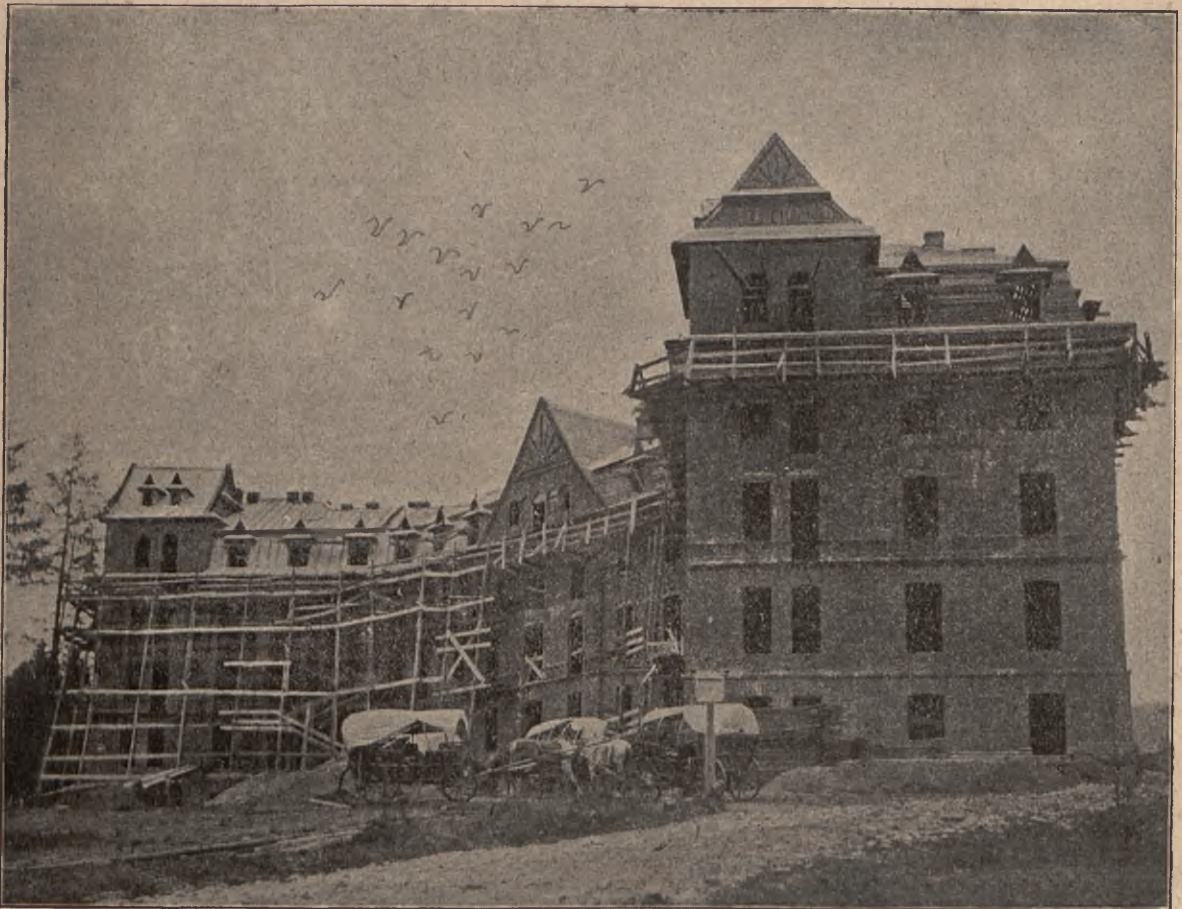
WIDOK BUDOWY SANATORYUM W ZAKOPANEM NA STOKACH GUBAŁÓWKI.
