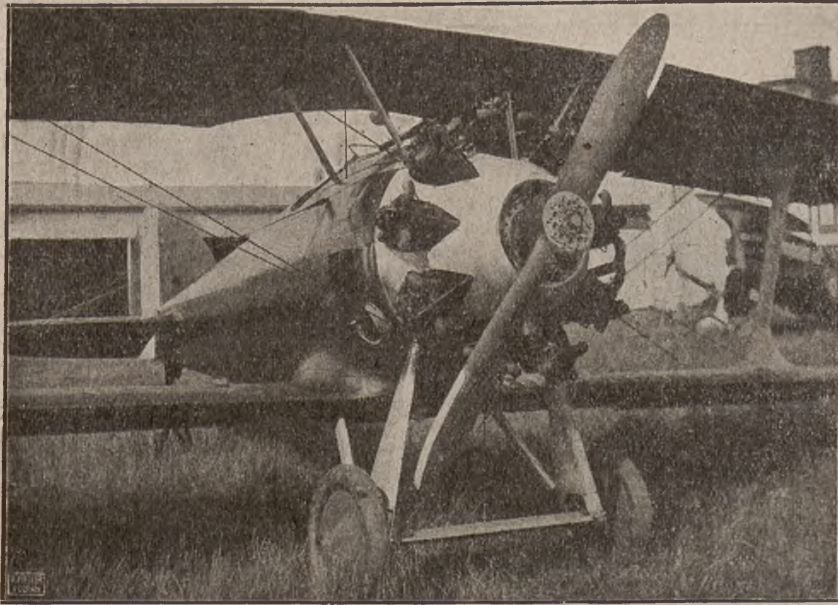
Platowiec pościgowy z wmontowanym silnikiem („Blerjot-Spad-51-Jupiter“).
