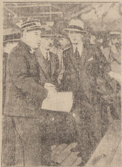
Der Beherrscher der Neuholzer Unterwelt erschossen
