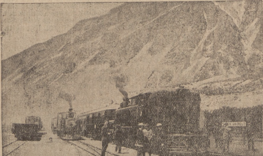
Tunnel-Einsturz beim Bau der neuen Anden-Bahn — 42 Tote
