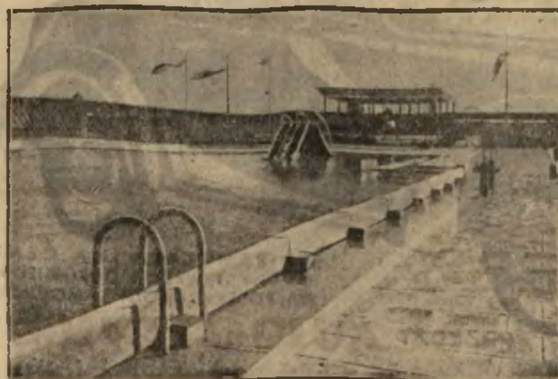
Basen pływacki solankowy w Ciechocinku. Całość urządzeń wykonana z żelbetu.
