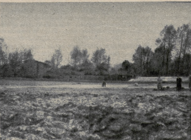
Dolne boisko Miejskiego Komitetu WF i PW na stadionie w Chorzowie. Widok na prace niwelacyjne boiska piłkarskiego. W tyle szatnie i część trybuny.
