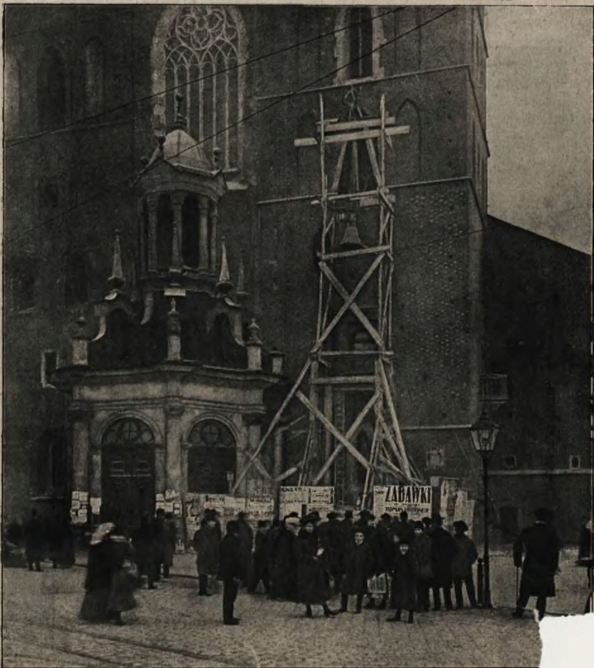
O ochrona zabytków przeszłości: Windowanie na wieżę kościoła Maryackiego dzwonu, naprawionego p
