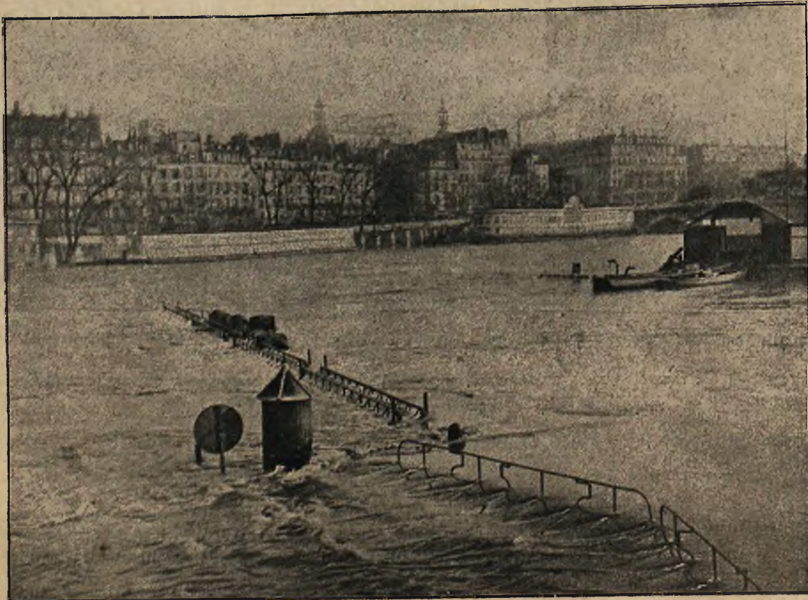
Straszna powódź we Francji: Jedna z głównych śluz na Sekwanie; zniszczenie tej śluzy spowodowało zalanie bulwarów paryskich.
