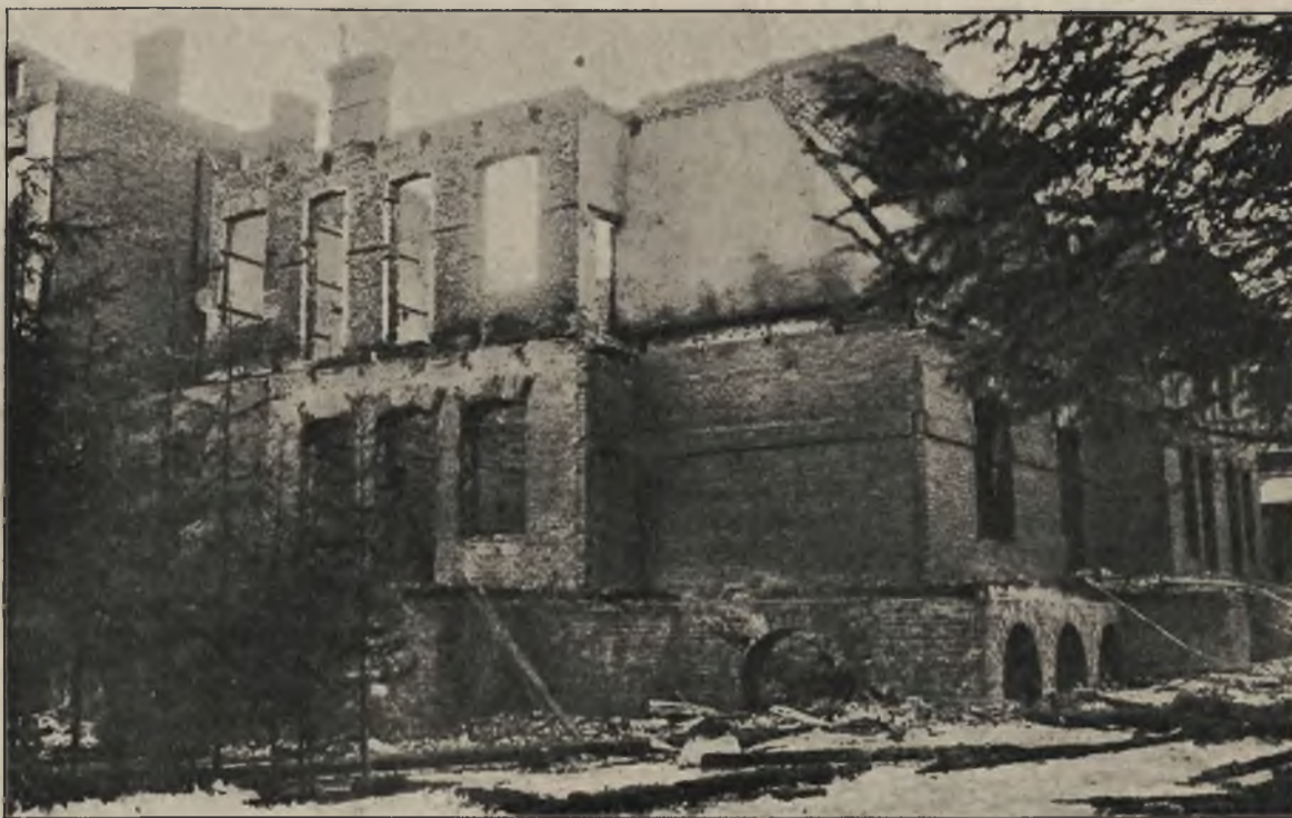
Wielki pożar w Zakopanem: Ruiny spalonego pensjonatu „Warszawianka“
