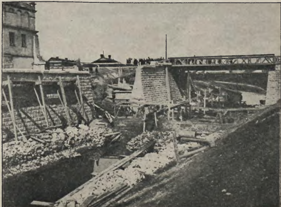
Nowe koryto Rudawy z nowym mostem.
