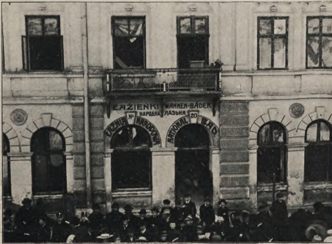
Fot. M. Todt, Przemysł. Katastrofa budowlana w Przemyslu: Ogólny widok domu przy ul. Mickiewicza l. 20. po katastrofie.
