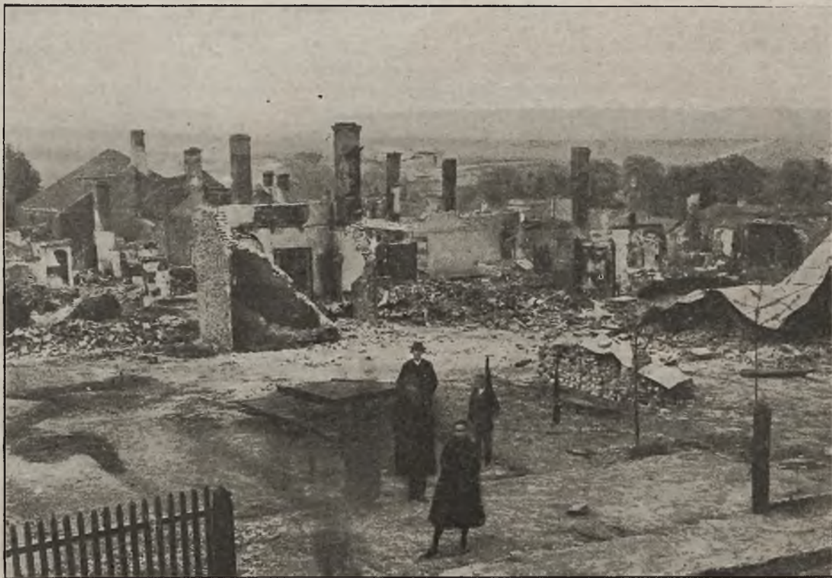
Pożar w Przemyślanach: Widok na część miasta, zniszczoną przez pożogę.
