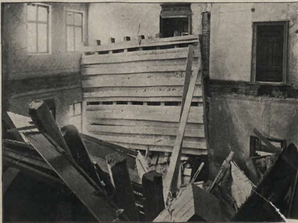
Katastrofa budowlana w Przemyślu: Wnętrze domu po zawaleniu się ścian bocznych i sufitów.
