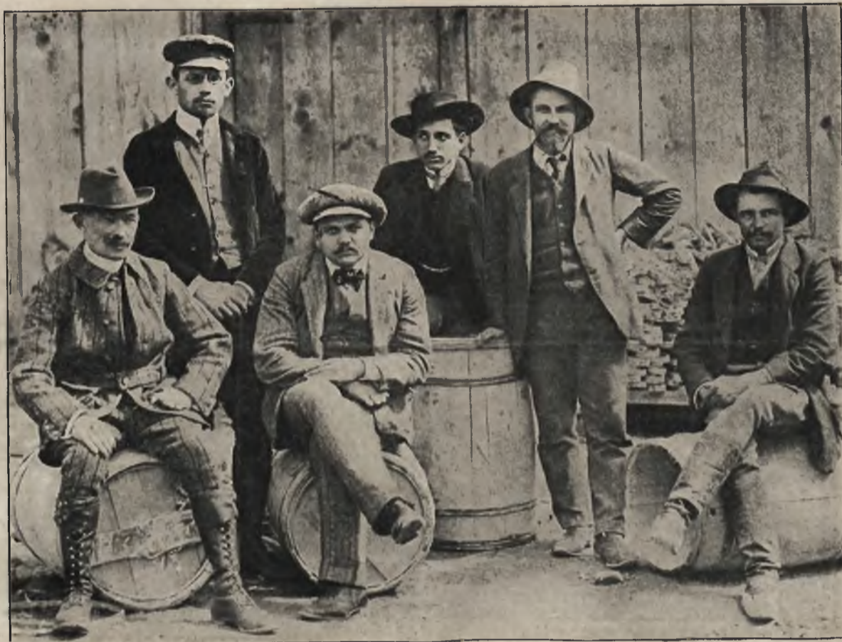
Wspaniały most: Personal techniczny, zajęty przy budowie mostu na Wisłoce.
