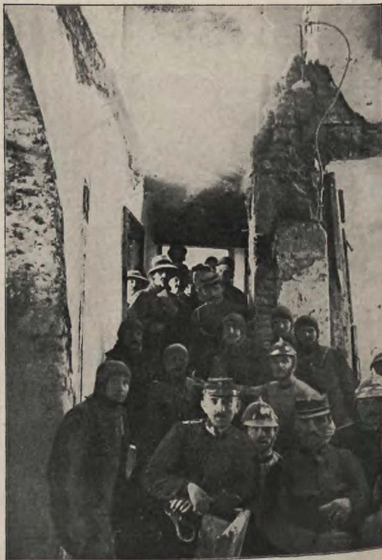
Zawalenie się kamienicy we Lwowie: W korytarzu wewnątrz zawalonego domu.
