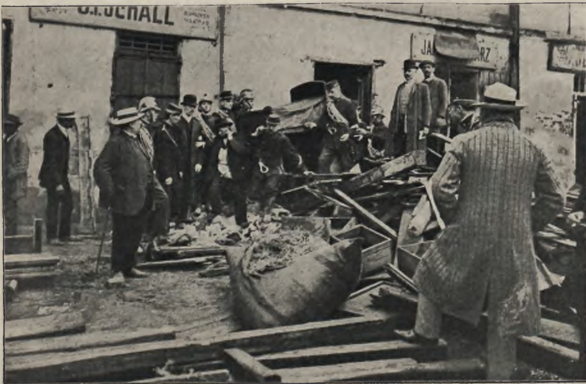
Zawalenie się kamienicy we Lwowie: Wynoszenie rannych i zabitych z wnętrza domu.
