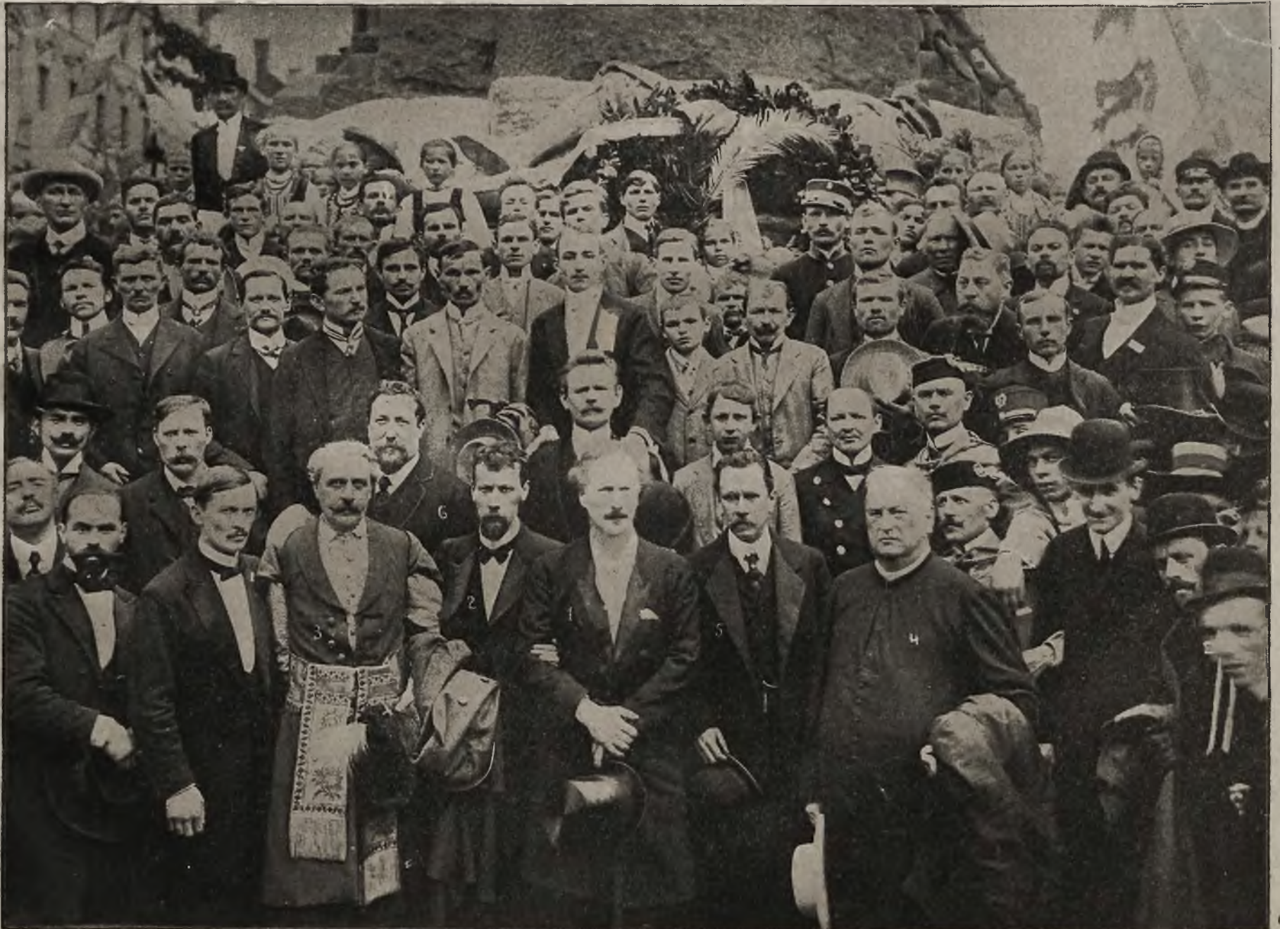
Grupa robotników i kierowników budowy pomnika Jagielly. 1. Fundator pomnika mistrz Paderewski; 2. Twórca pomnika artysta-rzeźbiarz Wiwulski; 3. Kierownik budowy architekt dr. Zubrzycki; 4. Ks. kanonik Drohojowski; 5. Pełnomocnik mistrza Paderewskiego p. Jenty z Warszawy; 6. właściciel odlewni Malessety.
