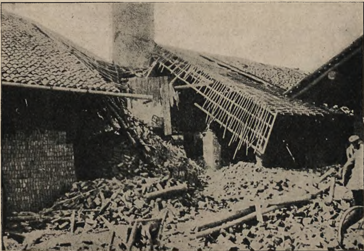
Cyklon w Lombardyi: Cegielnia w Solaro, zniszczona skutkiem cyklonu.
