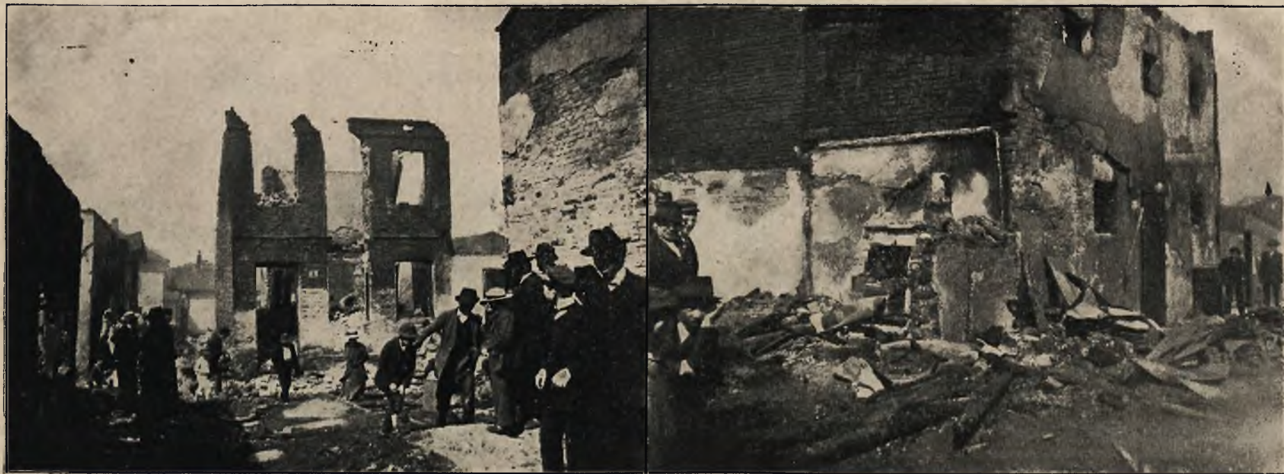
Dwie katastrofy żywiołowe w Kołomyi: Ruiny zniszczonych przez pożar domów.
