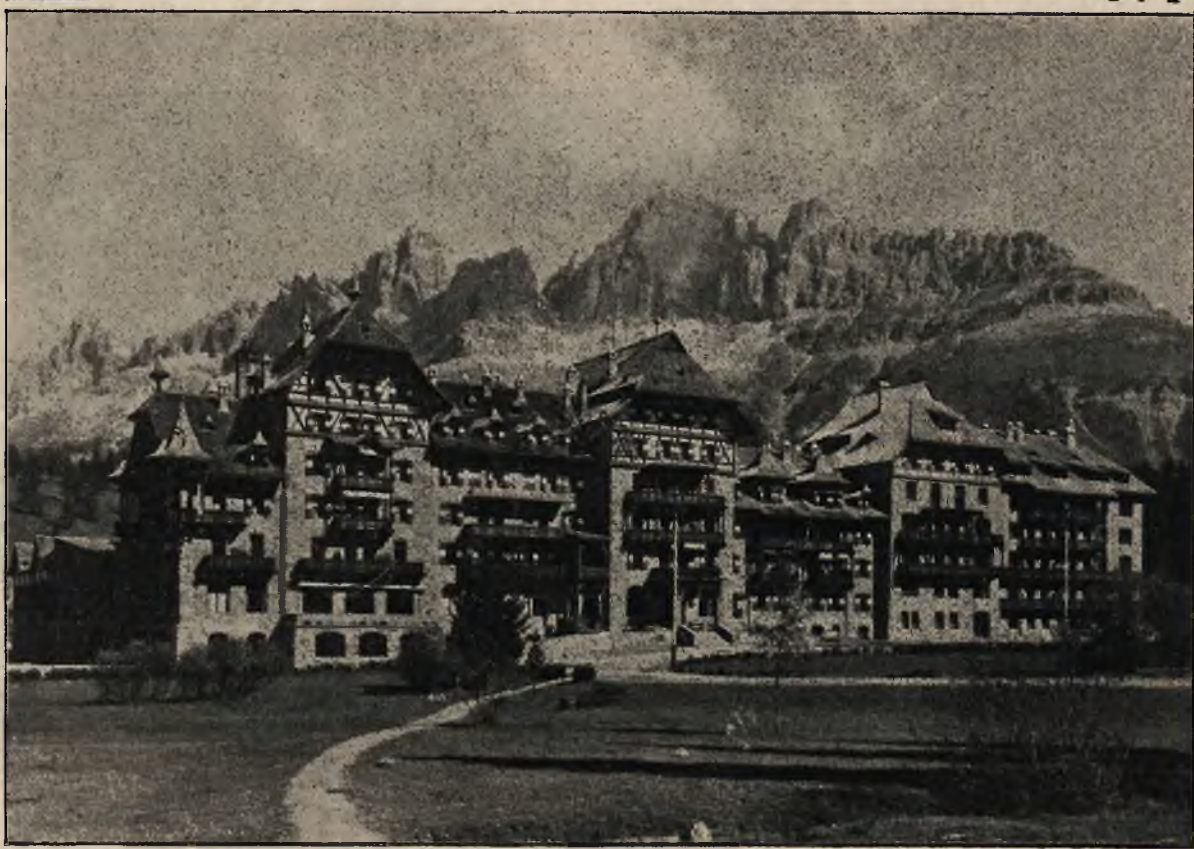
Pożar hotelu: Hotel Karersee pod Bozen w Tyrolu przed pożarem.
