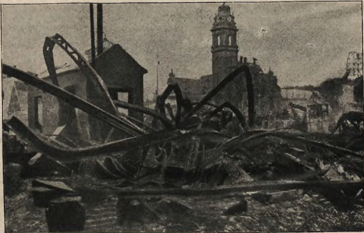
Pożar na wystawie w Brukseli: Resztki żelaznych konstrukcji, pozostałe po pożarze.
