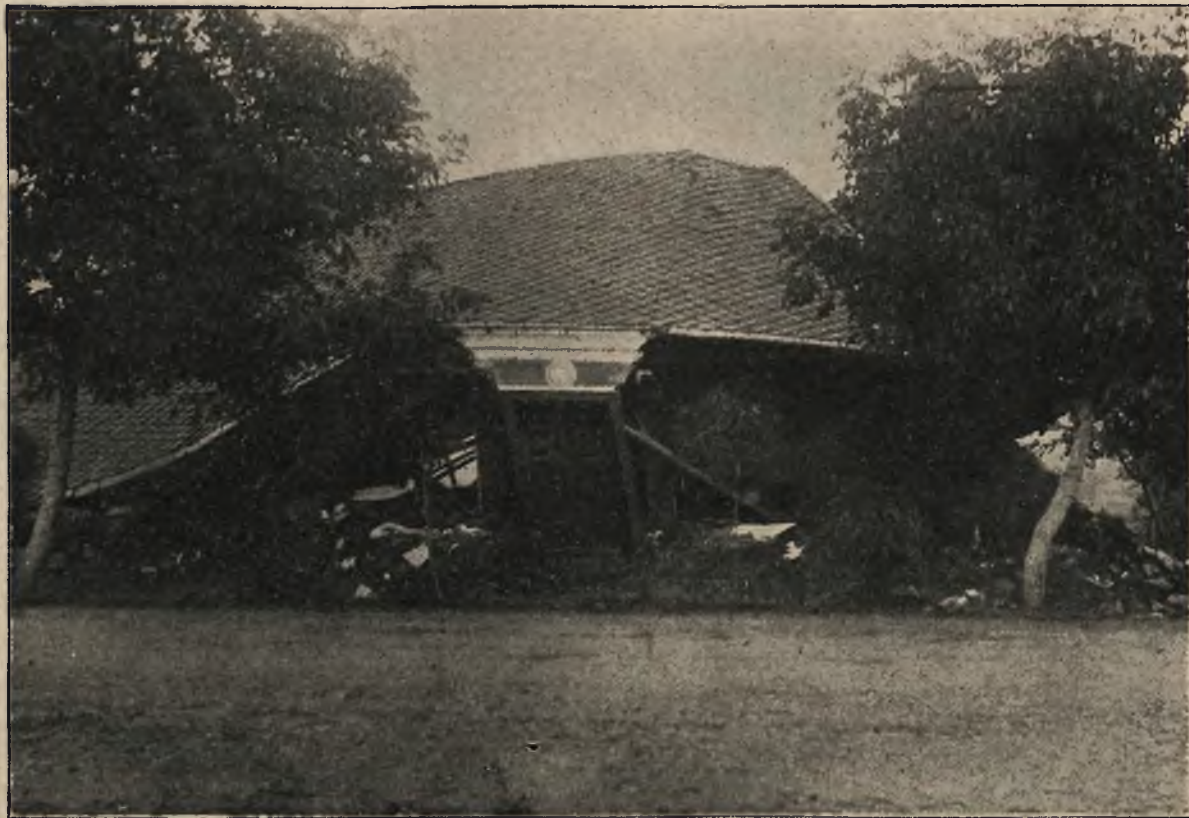
Powódź na Morawach: Zawalony wskutek powodzi dom w Kunowicach.
