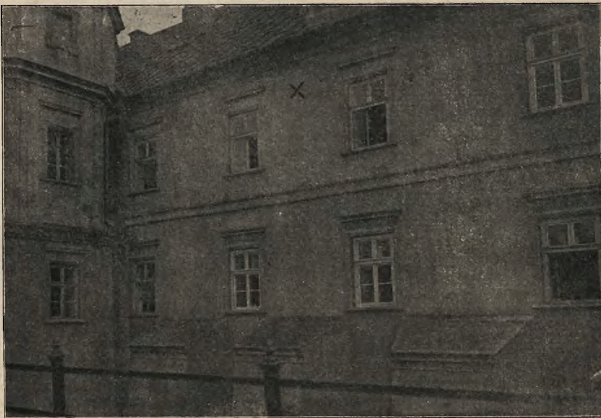
Wypadki na Jasnej Górze: Północna strona klasztoru na Jasnej Górze; na drugiem piętrze okna celi ks. Macocha. (X)
