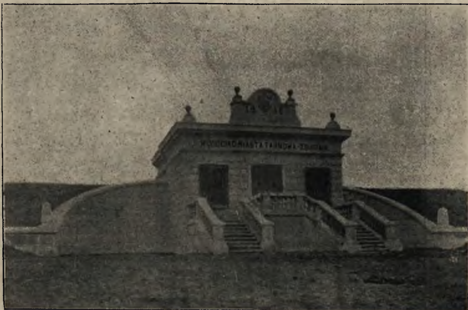
Milionowe inwestycje w Tarnowie: Zbiornik wodociągowy w Krzyżu z komrą zasów na froncie.
