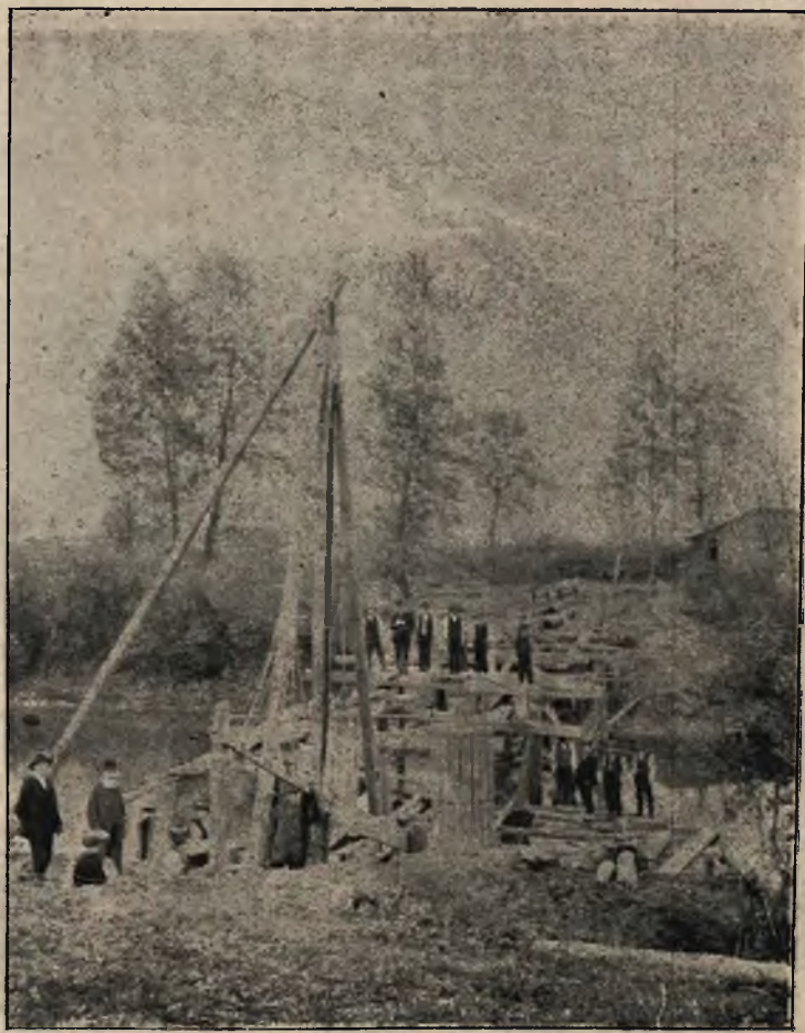
Milionowe inwestycje w Tarnowie: Roboty około przepustu przez rzekę Białą.
