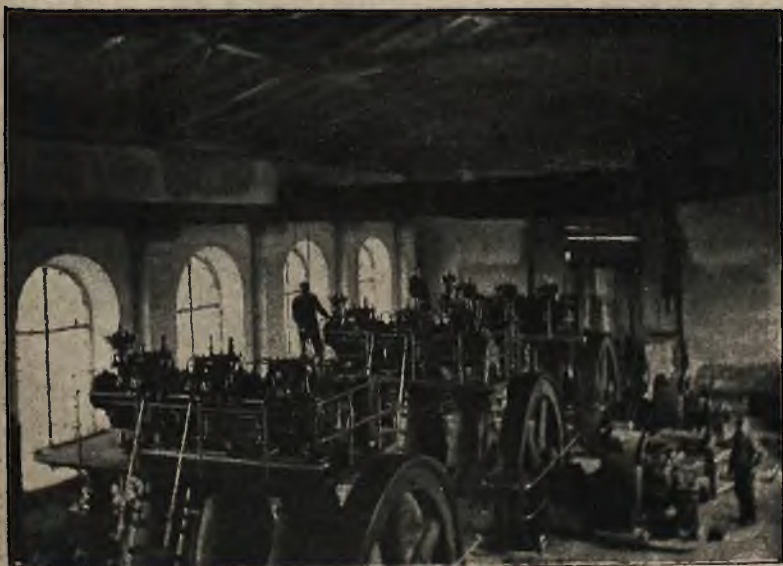
Milionowe inwestycje w Tarnowie: Hala maszyn elektrowni miejskiej
