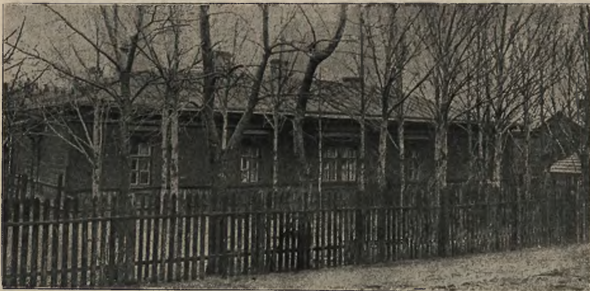
Po zgonie wielkiego pisarza: Dom stacyjny w Ostapowie, gdzie zmarł Lew Tolstoj.
