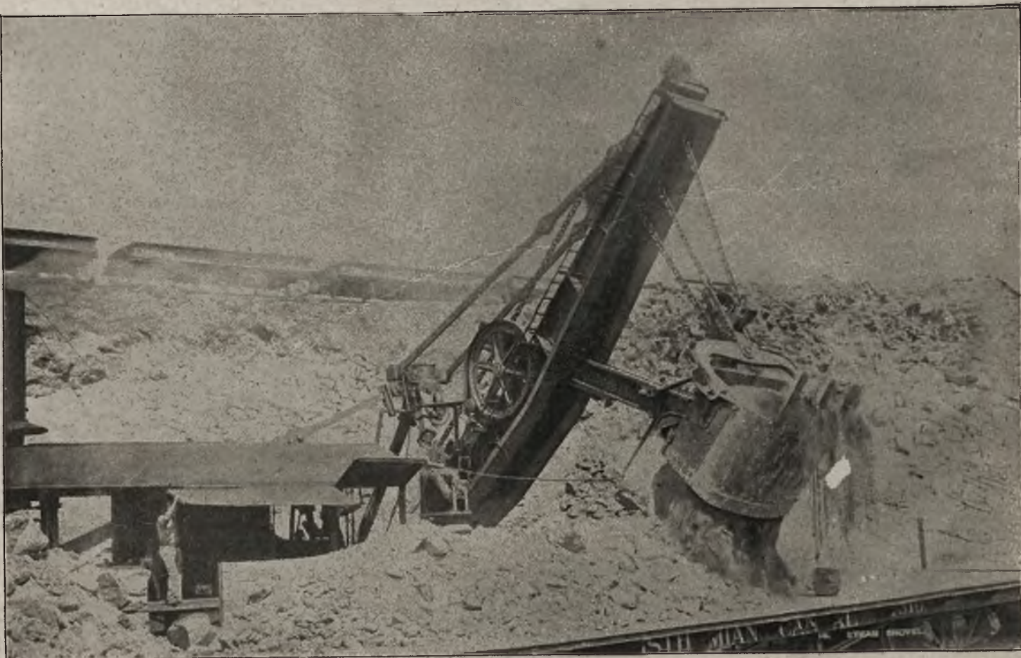
Roboty przy kanale panamskim: Olbrzymi bagger lądowy, dobywający naraz 1500 kg. ziemi.
