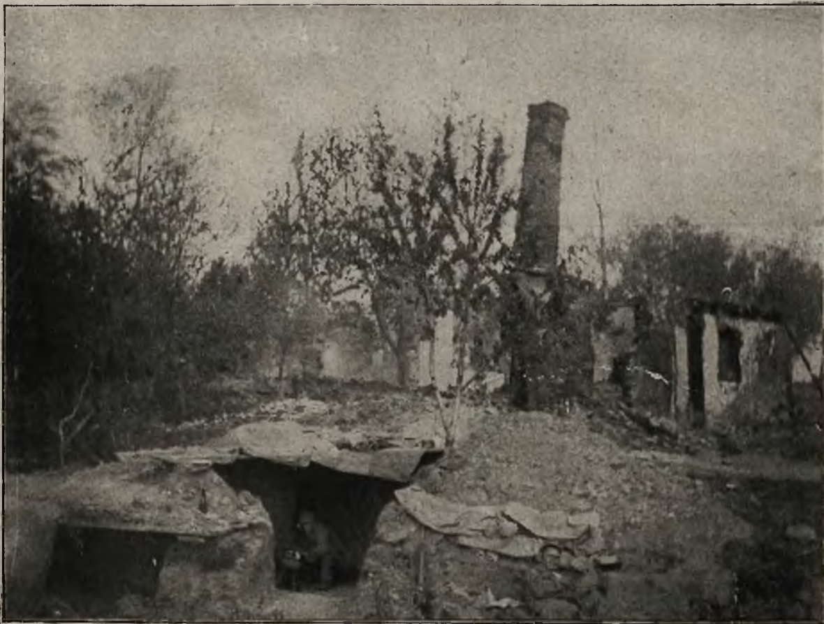
Szlakiem bojowym Legionów: Stacja telefoniczna Legionów (pod ziemią) w spalonej wsi.
