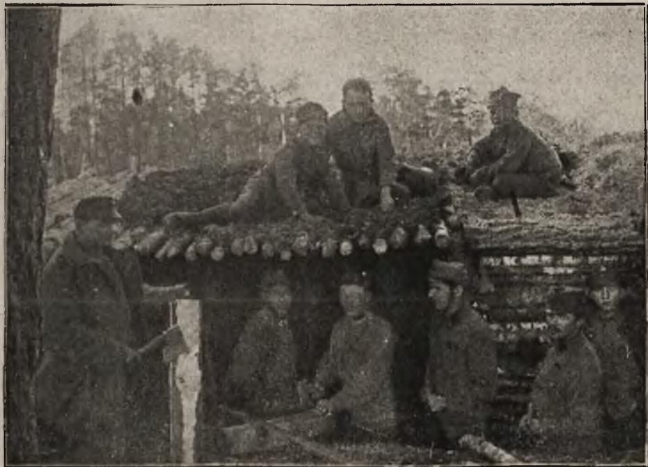
Budowa podziemnych mieszkań na linii bojowej.
