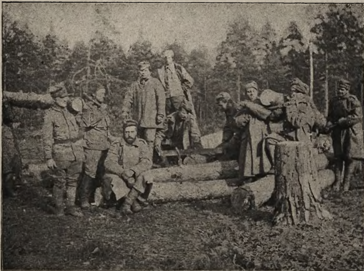
Szlakiem bojowym Legionów: Przygotowanie materiału do budowy okopów.
